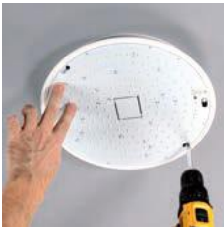
LED-levy kiinnitetään runkoon.
